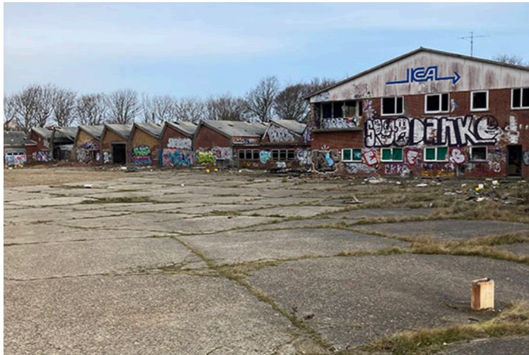
Brødfabrikken i Morsøgade
