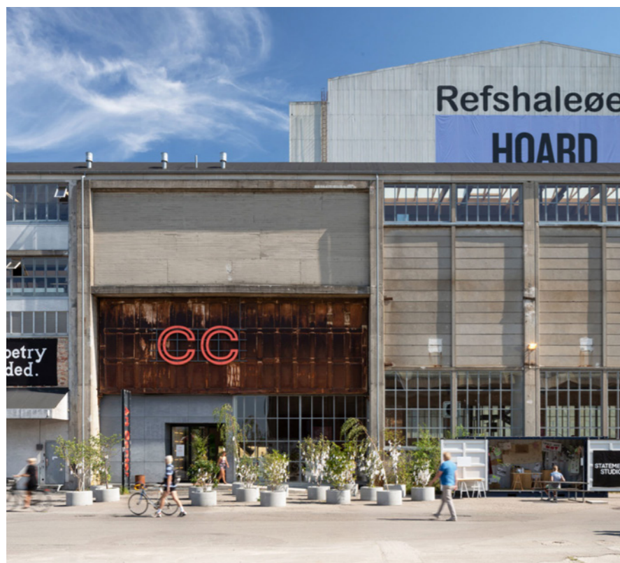
Billedet viser viser Copenhagen Contemporary der er et eksempel på en tilsvarende transformation af en industribygning. Bygningen der er en meget besøgt attraktion på Refshaleøen i København indeholder kunstgalleri butik mv.
